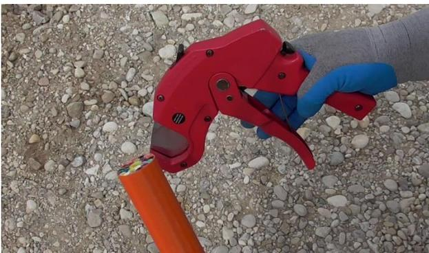
1.2 Zum Abschneiden des Endes vom Rohrverband, ein vom Hersteller empfohlenes Werkzeug verwenden. **Hinweis:** Der Schnitt darf nicht mit spanenden Werkzeugen (z.B. Säge) ausgeführt werden
